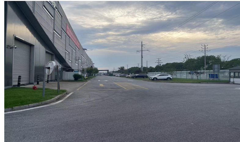
项目北：厂区道路
