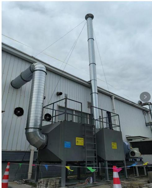
图 2-9 现有的二级活性炭吸附装置+15 米高的排气筒 DA003
