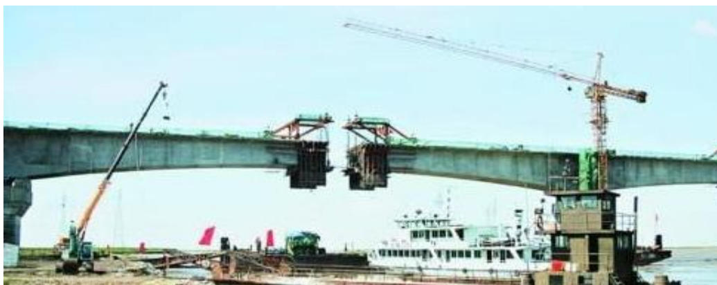
图 2-18 悬浇箱梁施工
