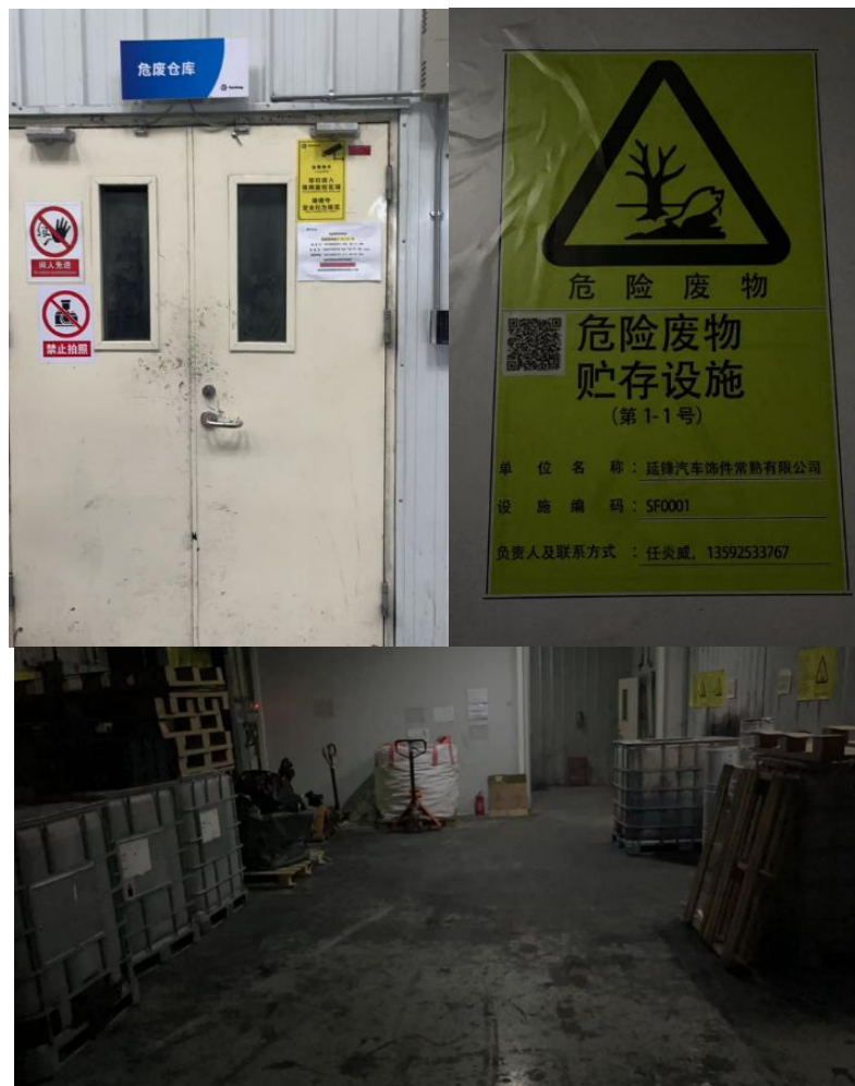
图 2-8 现有项目危废仓库
