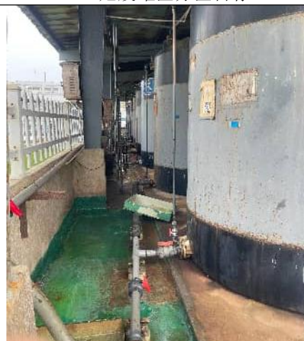
2-3 危废罐区地面防渗
