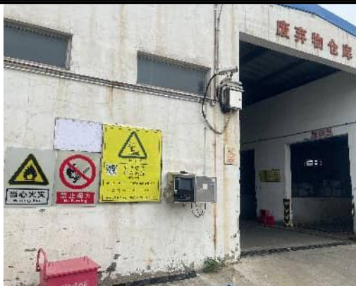
3-3 危废库外部标识及视频监控
