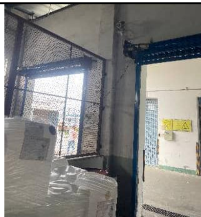
3-3 危废库内部视频监控
